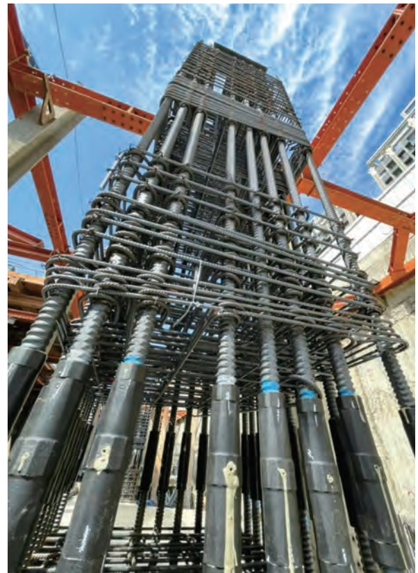
預組鋼筋籠搭配 SA 級鋼筋續接器施工 (統榮鋼鐵提供)
